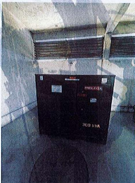
Fig. 11 Subestación Eléctrica #2 Tipo Pedestal de 300 KVA, 13,200-220/127 Volts.
