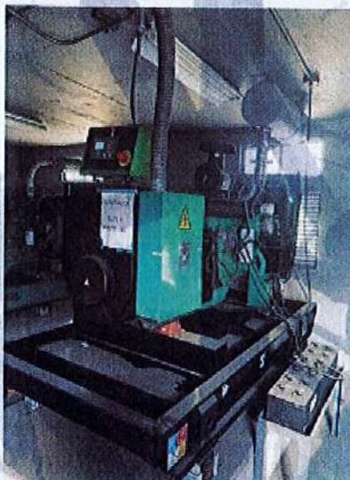
Fig. 10 Planta de Emergencia Trifasica de 100 KW, 480/277 Volts.
