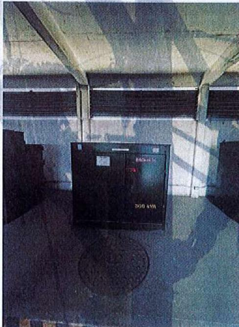
Fig. 5 Subestación Eléctrica #6 Tipo Pedestal de 300 KVA, 13,200-480/277 Volts.
